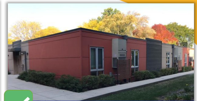
Zastępczy budynek modułowy
