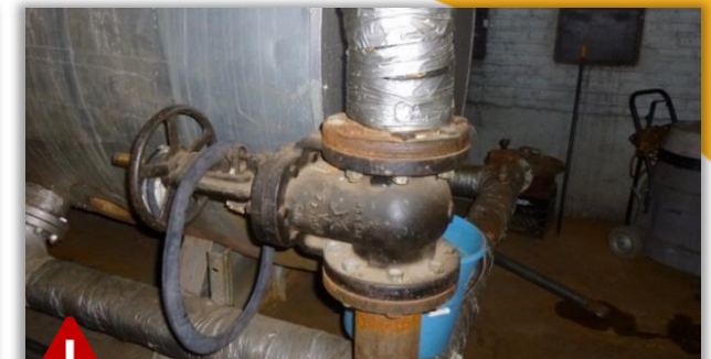
Uszkodzone rurociągi dystrybucji ciepła
