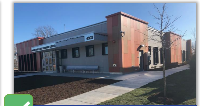
Nowy/zastępczy budynek modułowy
