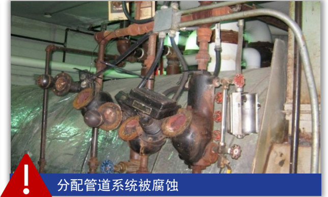
供热分配管道系统损坏
