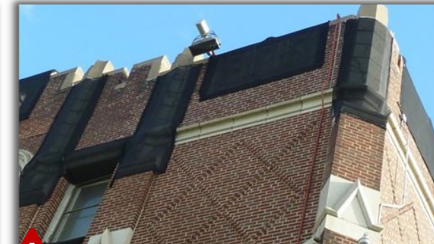
Tymczasowa stabilizacja erozji cegieł
