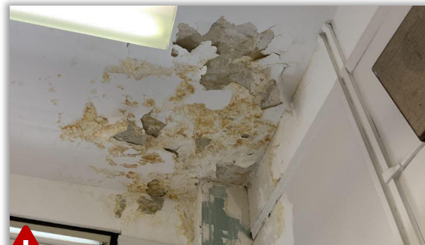
Zniszczenie tynku/wykończeń
