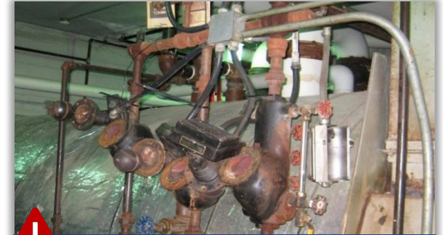
Corrosión en las tuberías de distribución
