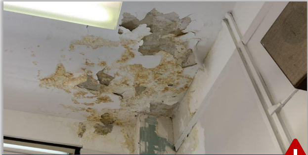
فشل الجص / التشطيبات الداخلية
