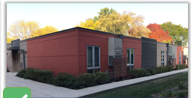
Reemplazo de la edificación modular
