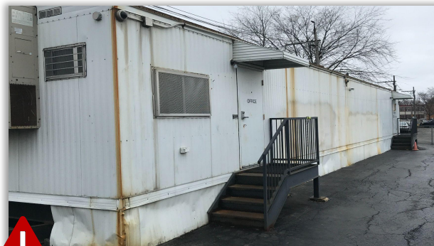
Edificación modular actual
