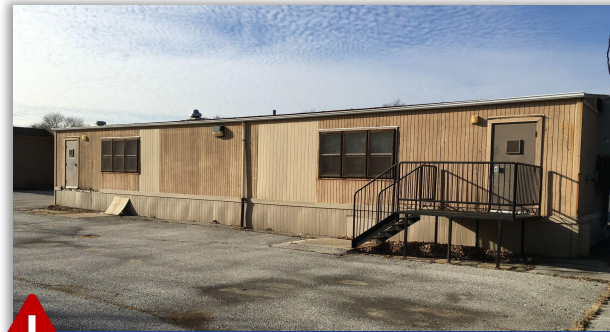
Edificación modular actual
